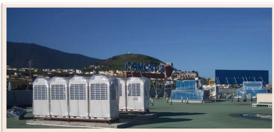
Instalación de aire acondicionado
