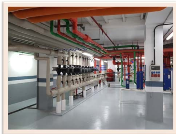
Remodelación de la sala de máquinas del Hotel Riu Garoé
