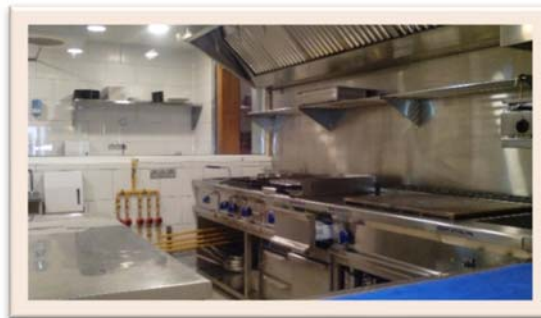
Remodelación de instalaciones en cocina del Restaurante La Brasserie
